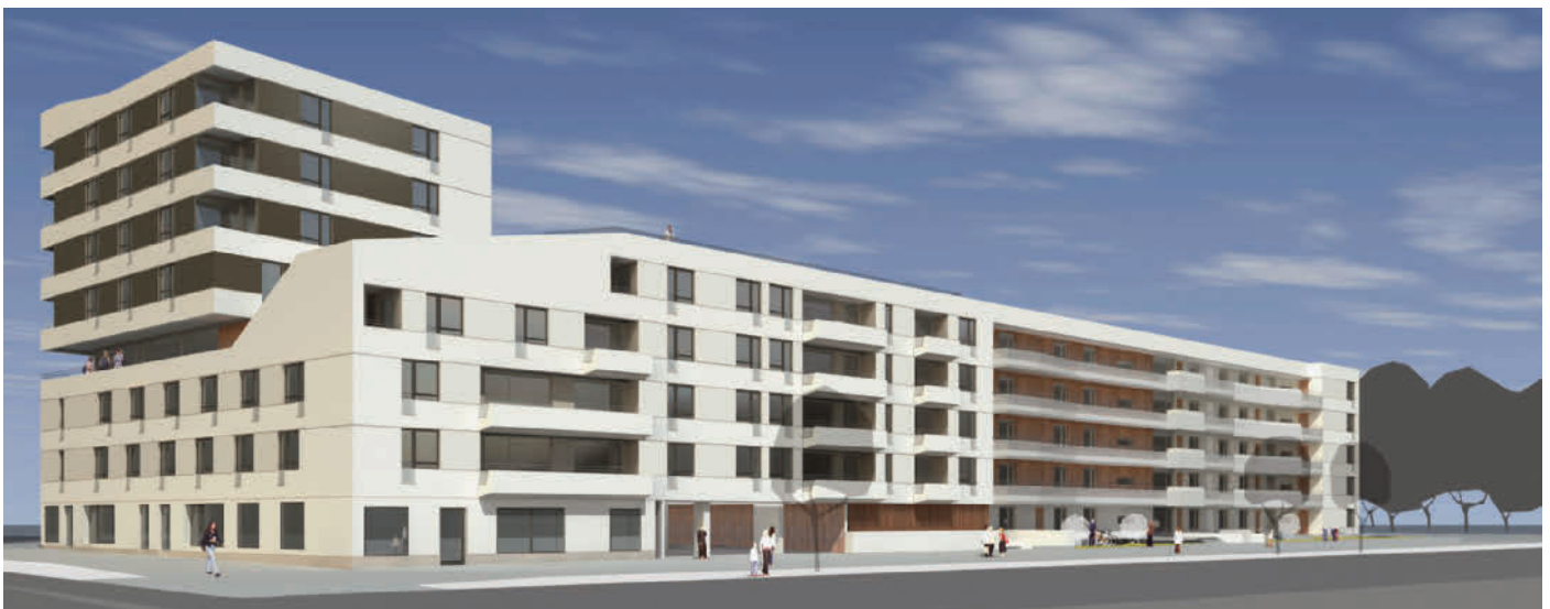
Am Domagpark wird ab 2015 auch die Fassade unseres Hochhauses PV-Strom liefern
